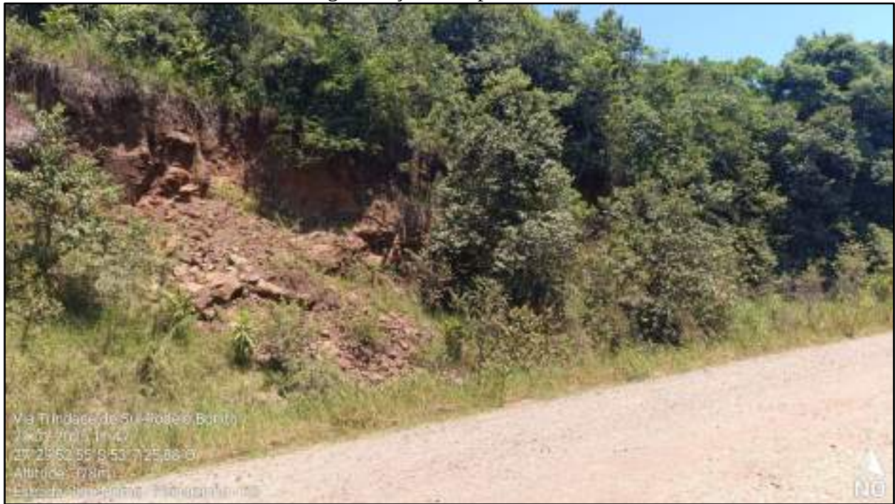
Figura 49. Surgência de talude de basalto exposto, no corte da estrada, onde a altura alcança 6 metros, possível verificar uma maior persistência de famílias de fraturas verticalizada, com ocorrência de fragmentação no topo do talude.
