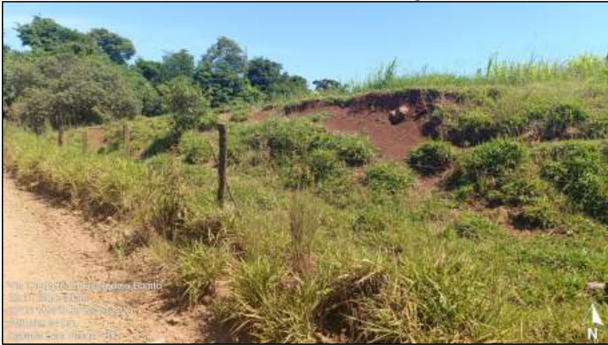
Figura 38. Camada de solo exposto de espessura superior até então encontrada, possuindo uma dimensão de cerca de 2,0 metros de largura.
