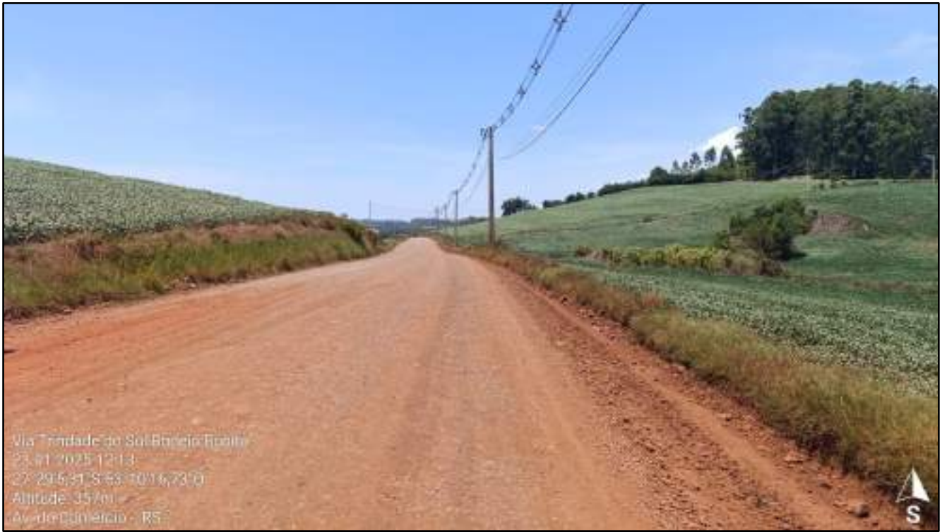
Figura 19. Visão parcial da situação geomorfológica a ser encontrada ao longo de todo o trecho da via levantada.
