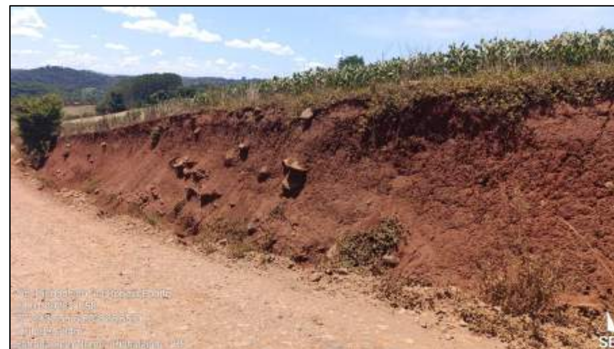
Figura 53. Vista aproximada da situação do solo nessa porção do trajeto.
