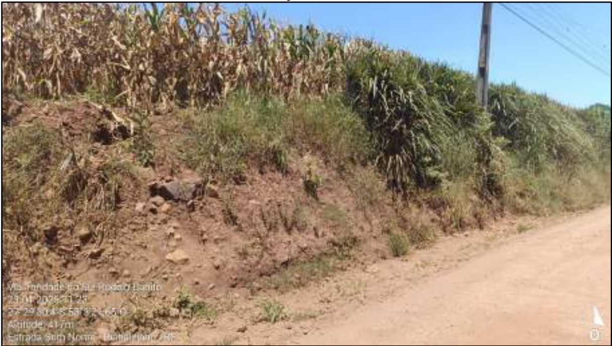
Figura 44. Começo de surgência de camada de maior relevância de solo, onde pode ser visualizada uma mescla com o basalto fragmentado encontrado em regiões próximas, com decomposição angulosa do maciço rochoso.
