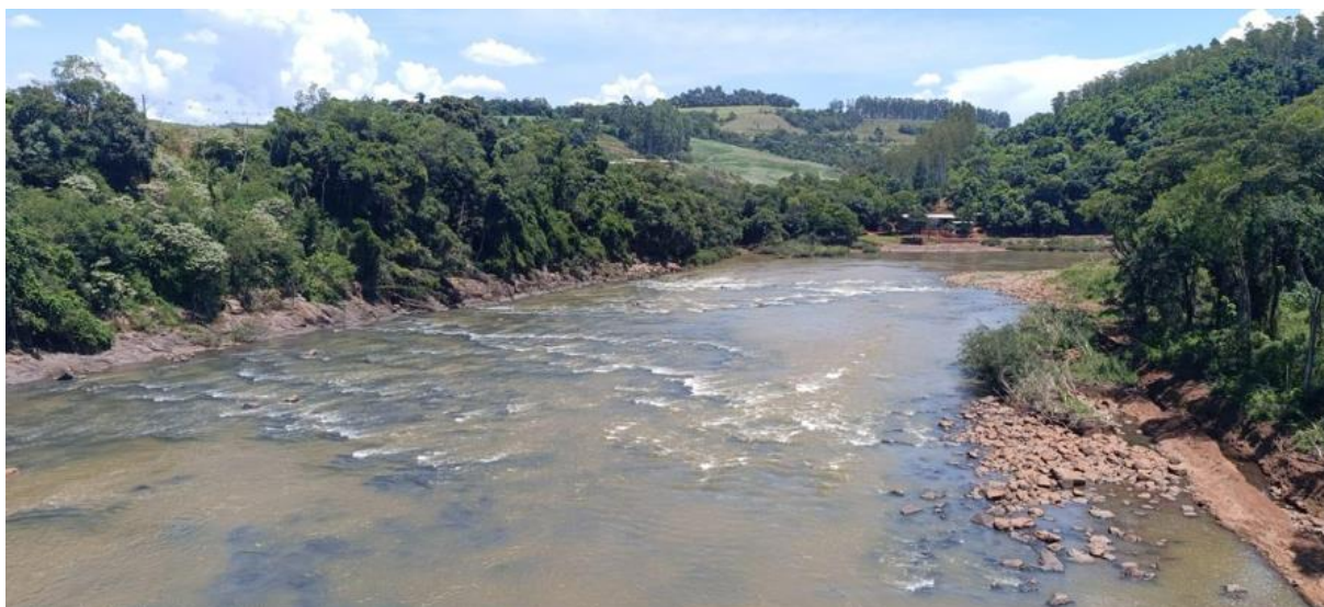
Figura 19 – Ponte sobre o Rio da Várzea – Divisa entre Rodeio Bonito e Liberato Salzano.
