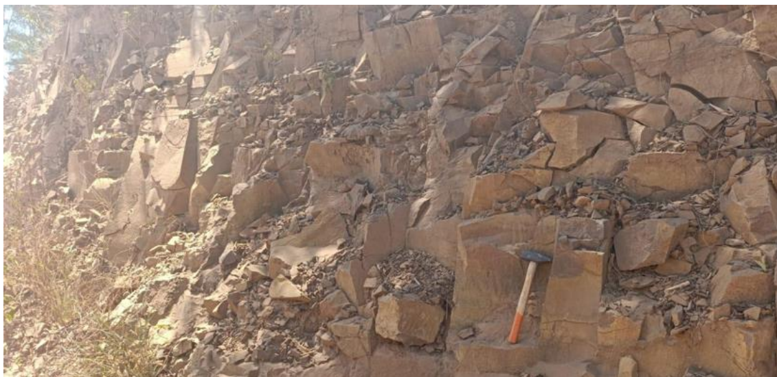
Figura 9 – Talude encontrado ao lado da estrada, apresentando as condições geológicas locais.
